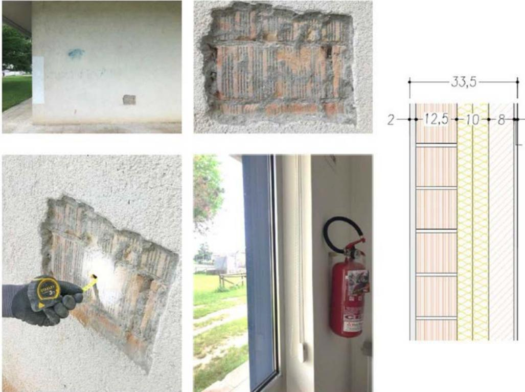
Allo stato di progetto si prevede l'applicazione di un sistema come di seguito composto:
