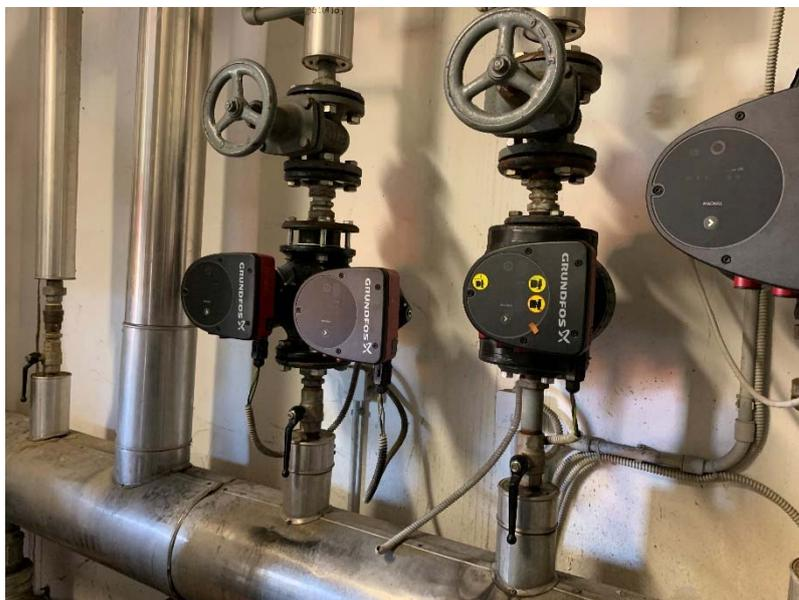
Figura 16 - 17 – palazzetto, collettore principale e circuiti secondari
