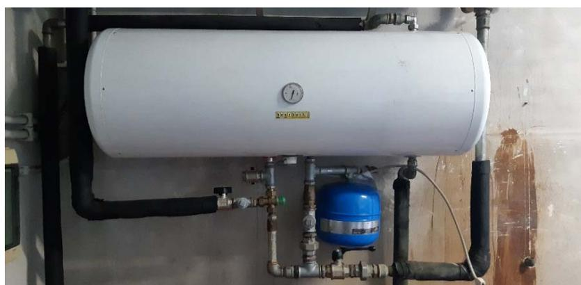
Figura 14 - Boiler termo-elettrico per ACS
