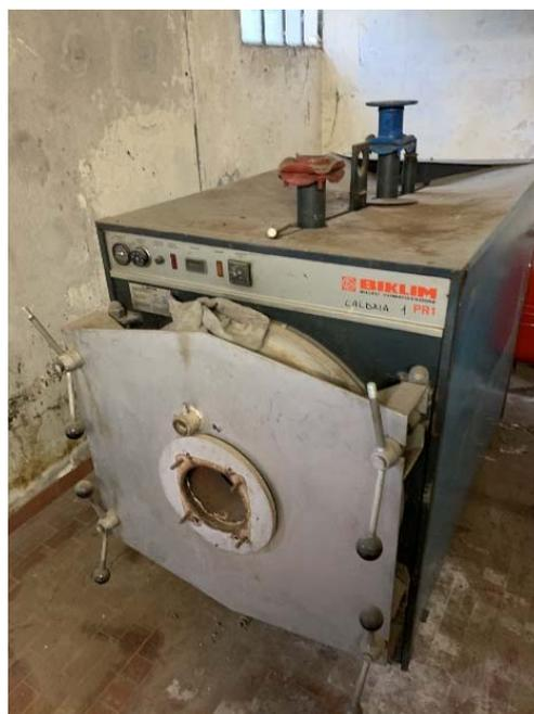
Figura 7 e 8 – scuola primaria ,caldaie a gas naturale
