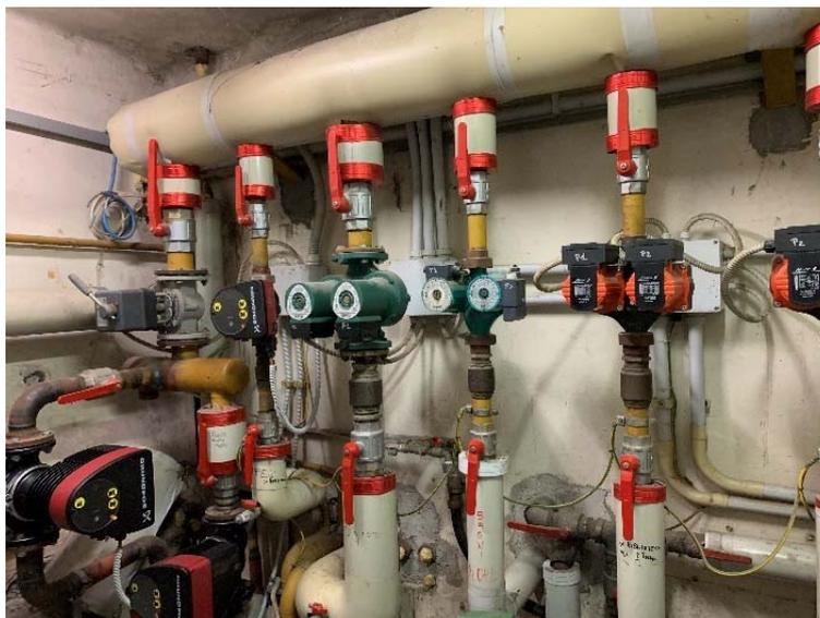
Figura 9 - scuola primaria - sotto-centrale termica , collettore principale e circuiti secondari
